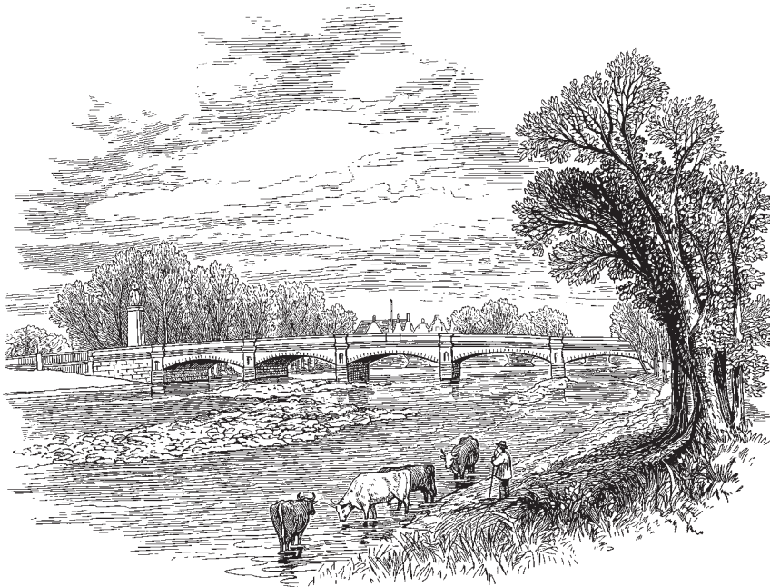
Abb. 65. Brücke über den Esk bei Musselburgh.
