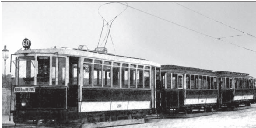
Abb. 6. 31 m langer Dreiwagenzug der städtischen Straßenbahn Wien, bestehend aus einem neuen Triebwagen und zwei Anhängewagen. Leergewicht 24 200 kg, 66 Sitzplätze, 68 Stehplätze, also insgesamt normal für 134 Fahrgäste.
