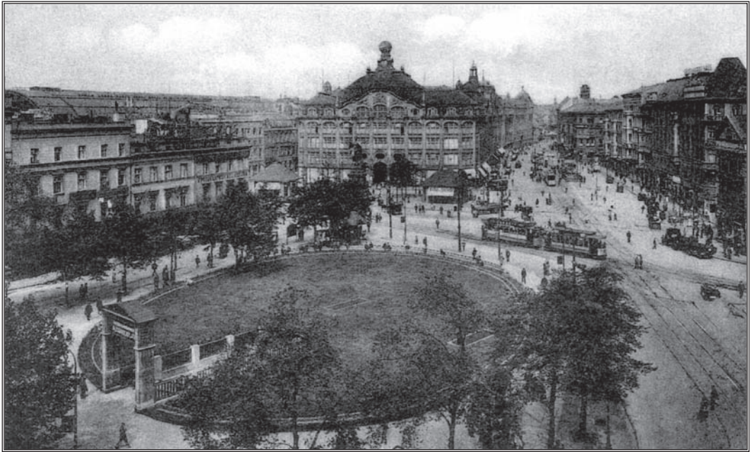
Abb. 66. Der Alexanderplatz um 1910 mit dem Eingang zur Untergrundbahn.
