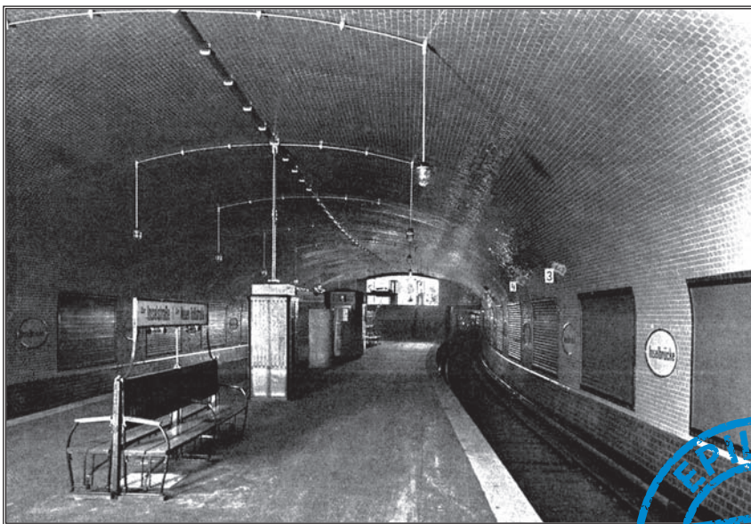
Abb. 68. Innenraum des Bahnhof Inselbrücke.
