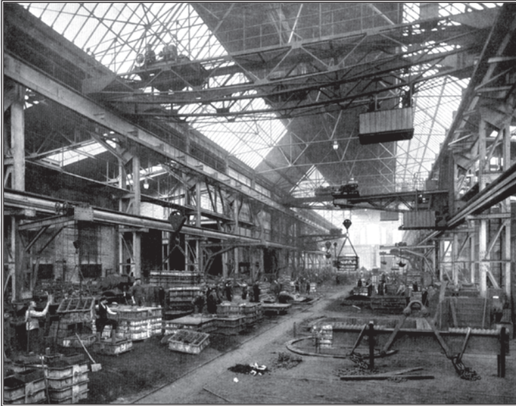
Eisengießerei • Mittelhalle für schwere Gussstücke • Flächeninhalt der Gießerei mit Anbauten 6560 m 2 Belegschaft 350 Mann • Leistungsfähigkeit im Jahr 8000 t Maschinenguss
